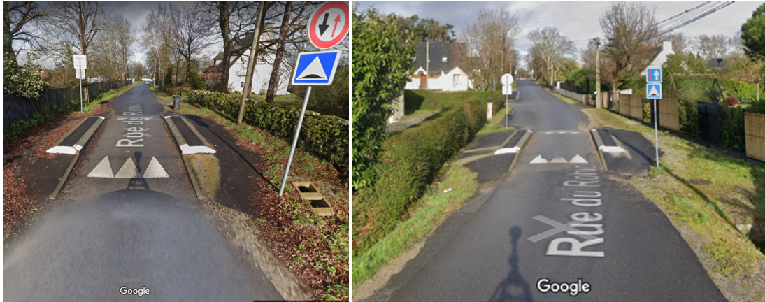
Exemples de ralentisseurs équipant la rue du Rohic (source Google Street View)
